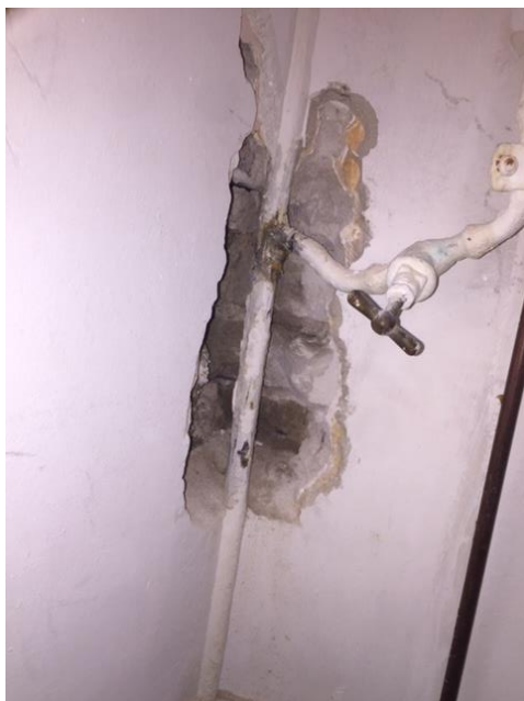
Afb 1 - stijgleiding lood in stucwerk 1
